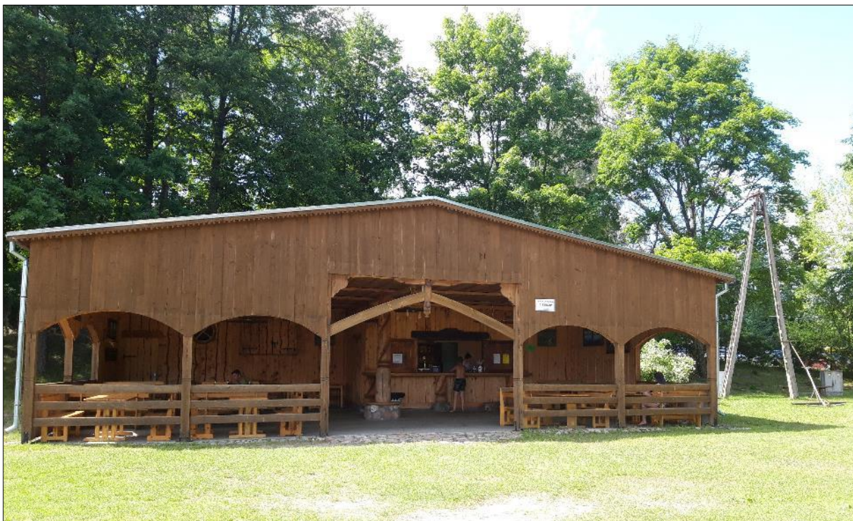
Fot. 8 Wiata gastronomiczna na terenie Upk. 01 (Fot. MdProject)
