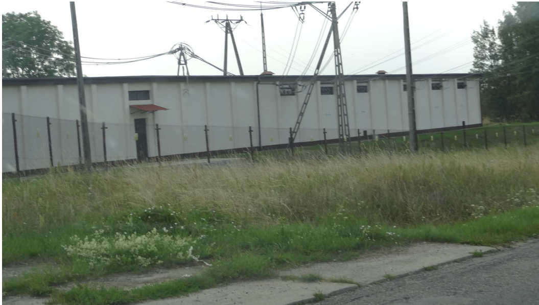
Fot. 3 Fragment drogi powiatowej oraz terenu elektrowni.
